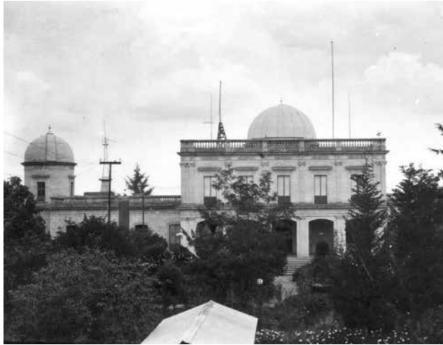
Figura 2. Edificio Central del Observatorio Astronómico de Tacubaya.
