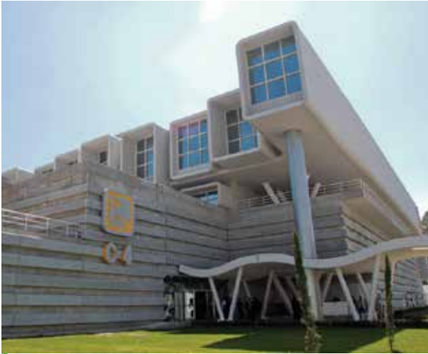
Figura 3. Centro de Control.
